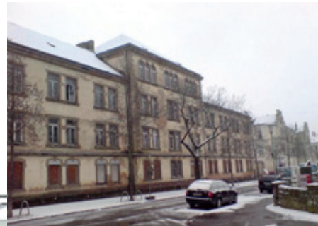
aktueller Zustand Gneisenau
