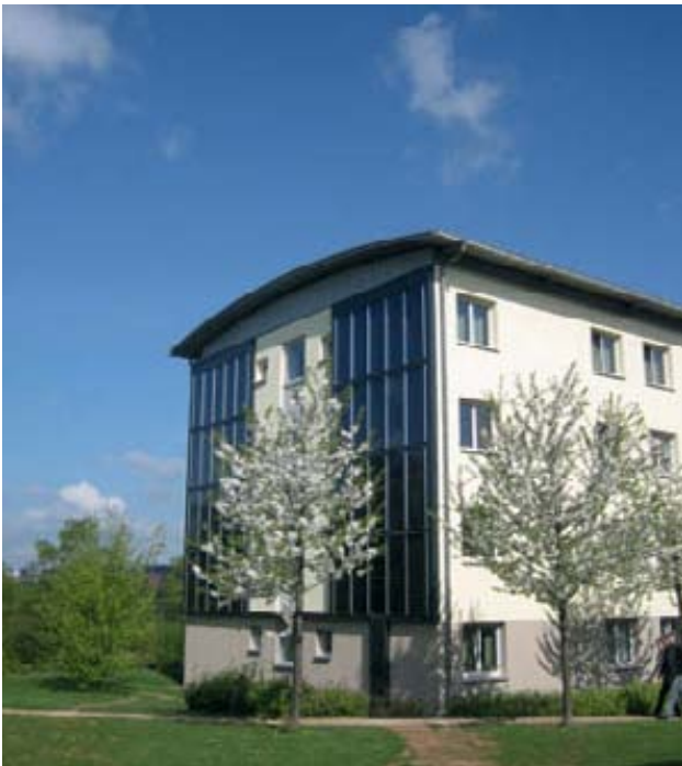
Solarthermie an der Fassade statt auf dem Dach
